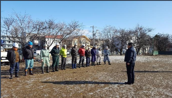
午前8時半作業開始 安全確認
